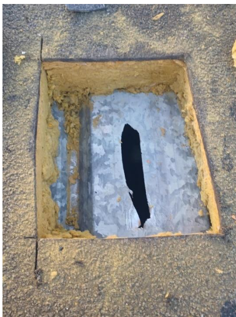
Prélèvement Géotec avant remise en état
