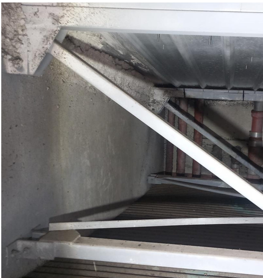
Photo de l'assemblage poutre treillis / poutre longitudinale béton armé
