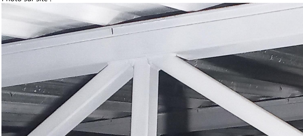
Les éléments des treillis PT1 soudés entre eux
