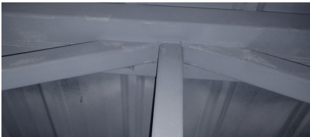
Les éléments des treillis PT3 (avec doublement des membrures) soudés entre eux
